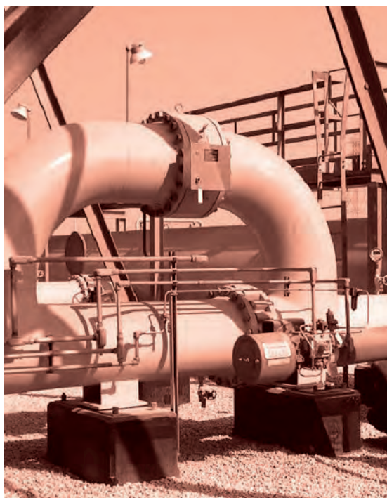
Knickstabentlastungsventil installiert als Inline-Bypass zum Steuerventil an einem Gasfackelsystem
